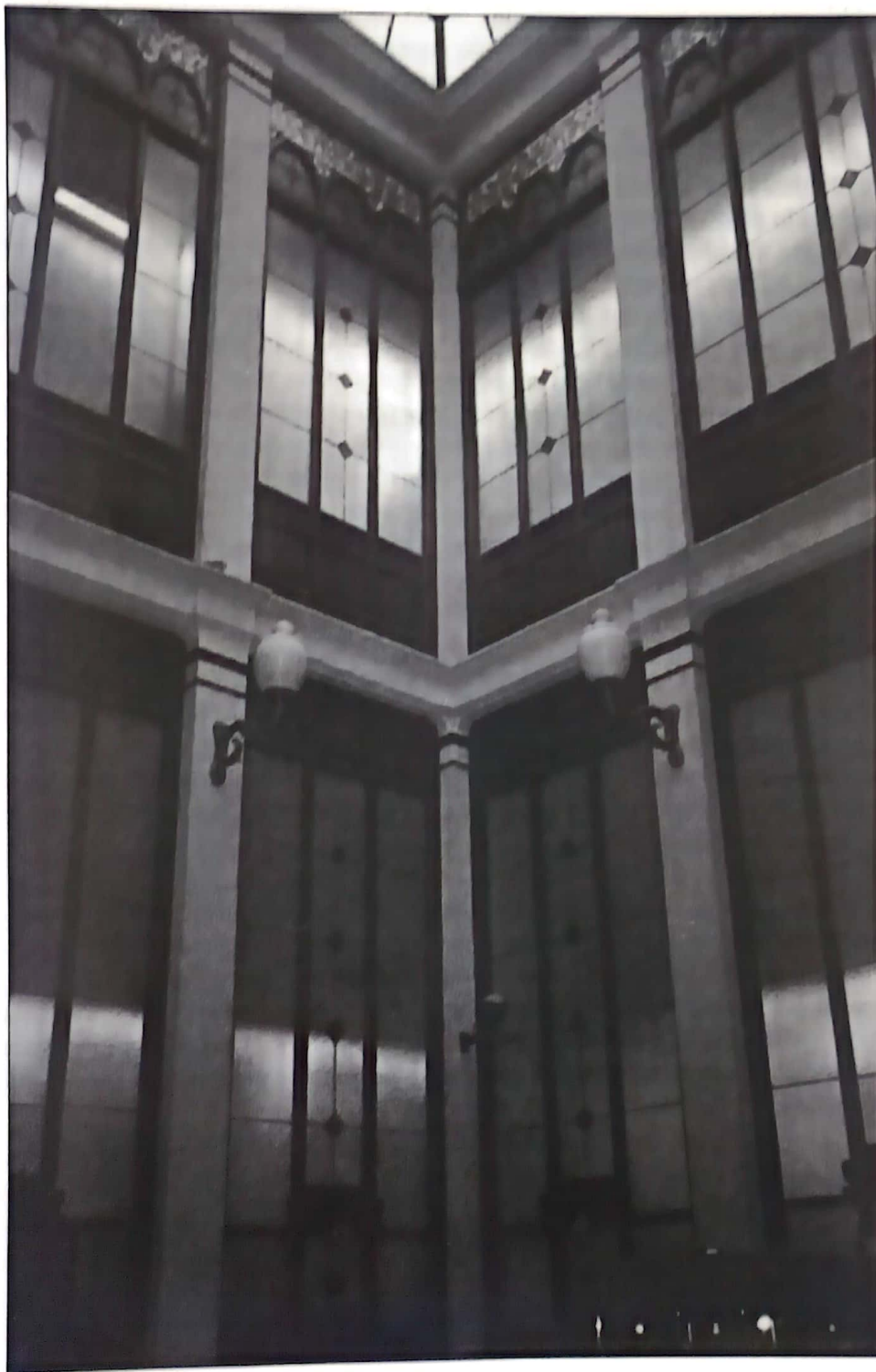
Vestíbulo de Correos. En torno al vestíbulo se articula todo el edificio.
