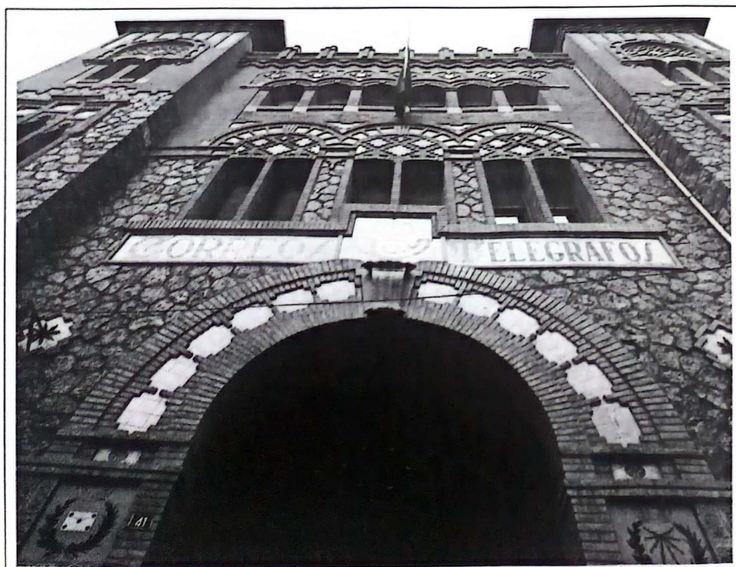
Vista parcial de la fachada principal.
